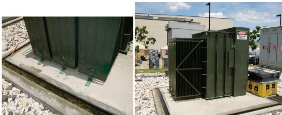
איור 6.4.7.3-5 – שני שמן חיצוני הממיר מתח עבור מתקן חשוב. שימו לב לרכיבים האלכסוניים על המצנן במטרה למזער את ההעמסה הדינאמית על מיכל הנוזלים המכיל מספר חיבורים מרותכים.
