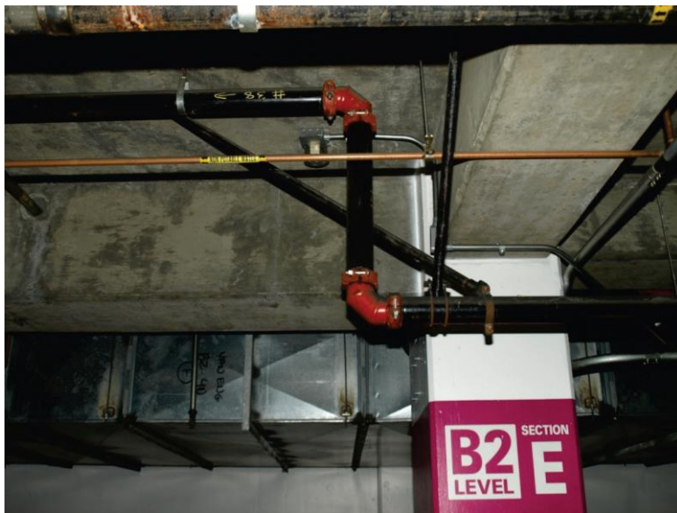
איור 6.4.4.1-9 – עיגונים בכיוון האורכי והניצב עבור קו מערכות כיבוי אש.
