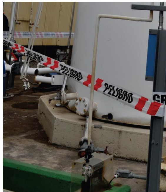
איור 3-6.4.5.1 – נזק למיכלי דלק שעוגנו באופן לקוי שגרם לפגיעה בקווי אספקת הדלק. תמונת התקריב מציגה כשל בצינור באזור מחבר מרוחק (משמאל) ומקטע צינור עם שסתום מחובר (בחזית) שנתלש מתוך המיכל.
