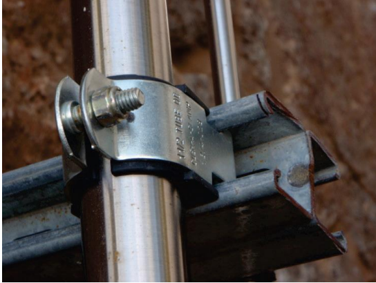
איור 7-6.4.5.1 – צנרת המכילה חנקן. מתחת למחבר החובק את הצנרת ישנו גומי מותאם בכדי להגן על פלדת הצנרת.
