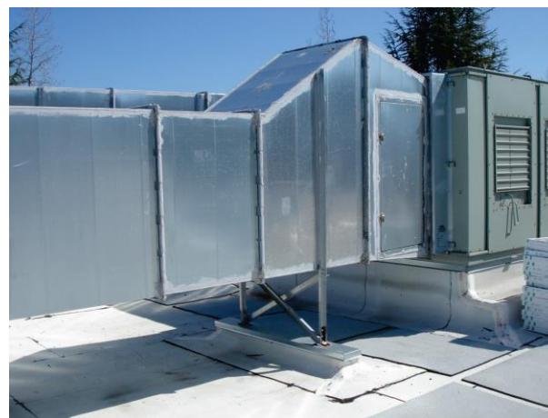
איור 6-6.4.6.1 – תעלה מלבנית המחוברת לגג ונתמכת על ידי מבנה פלדה ייעודי.
