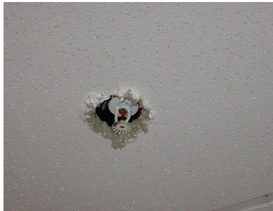
איור 7-6.4.4.1 – דוגמא להתנגשות בין יחידות מתזי המים לסוגים שונים של גימורי תקרה אשר הובילו לנזק בתקרה ובמתזים ולנזקי רטיבות בשדה תעופה.
