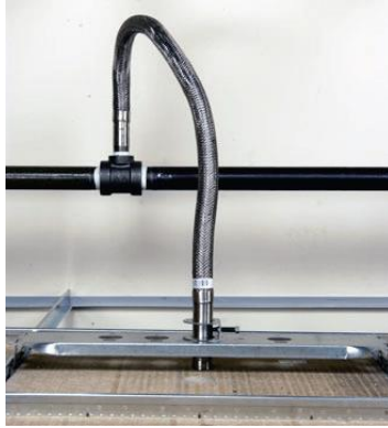
איור 10-6.4.4.1 – צינור גמיש המחבר בין קו מתז מים לתקרה. חיבור זה מאפשר ליחידת המתזים לנוע בחופשיות עם התקרה התלויה ללא גרימת נזק למערכת הכיבוי.
