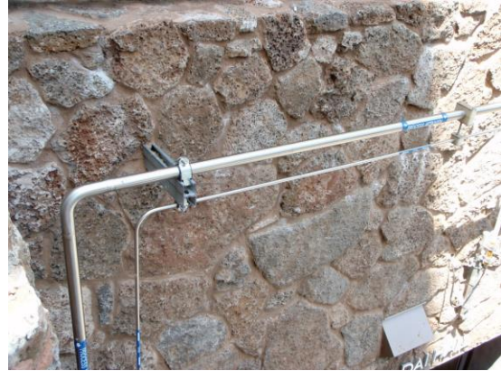
איור 7-6.4.5.1 – צנרת המכילה חנקן. מתחת למחבר החובק את הצנרת ישנו גומי מותאם בכדי להגן על פלדת הצנרת.
